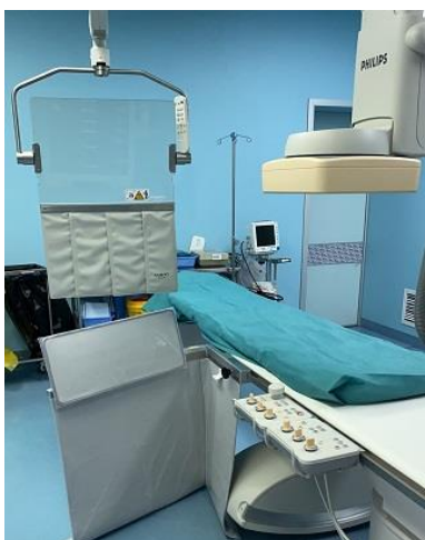
图 4-2 第二手术室机房内辅助防护设施
